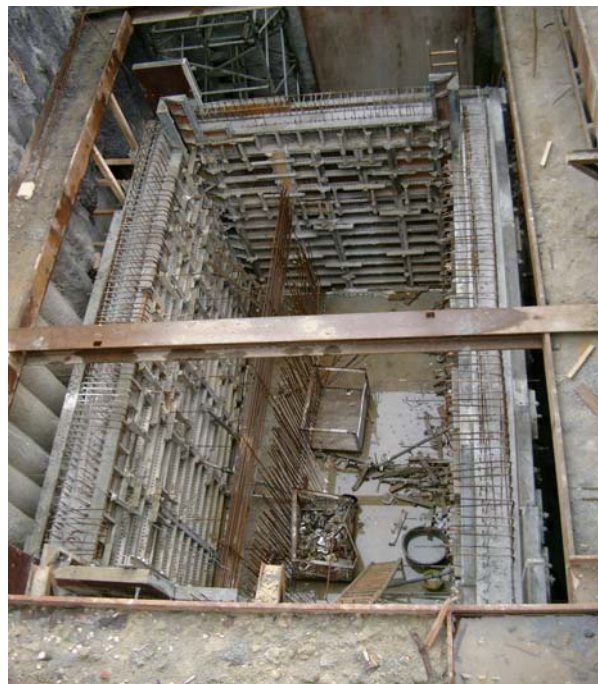
Anfahrphase 1. VT-Rohr - Trennbauwerk in ehem. Pressbaugrube mit überschrittenen Bohrpfehlen
