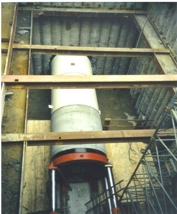
Anfahrphase 1. VT-Rohr - Trennbauwerk in ehem. Pressbaugrube mit überschrittenen Bohrpfehlen
