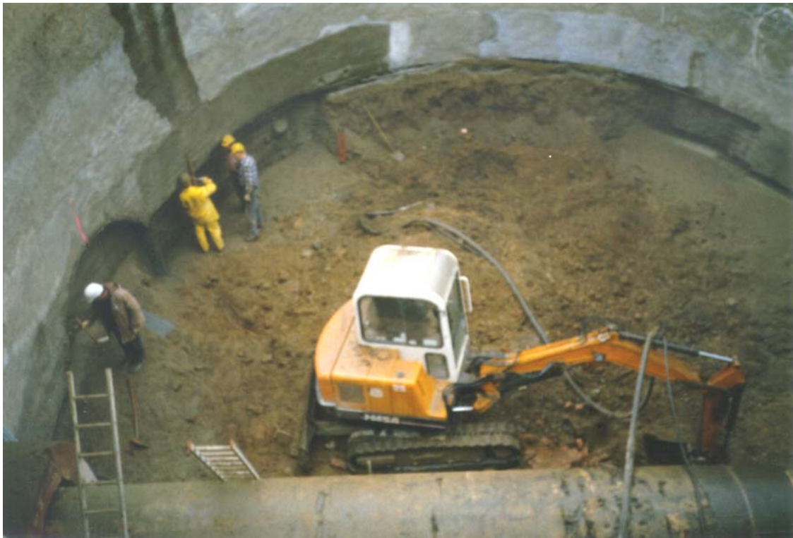
Pressbaugrube für DN 3200
