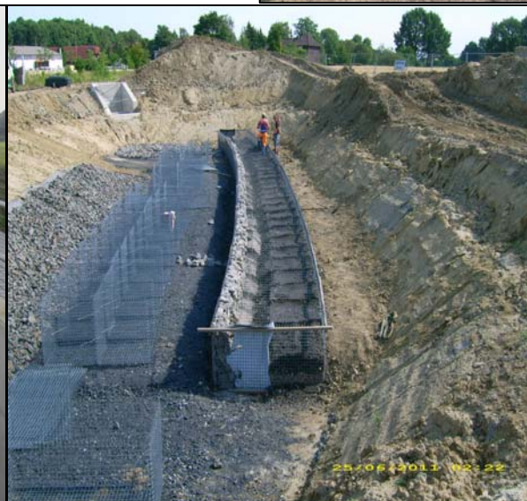
Herstellung Gabionenstützwand im RRB
